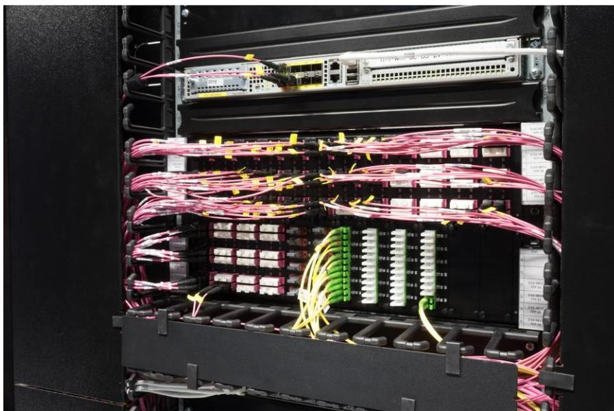
Zusätzlich wurde das DVAG-Rechenzentrum mit 29 LCC Trunks mit einer Gesamtkabellänge von 743 Metern bestückt.
